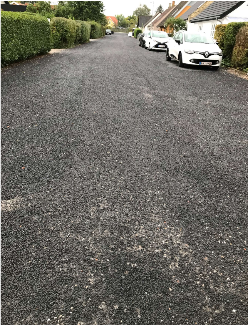
Foto 13: 1 år gammel Sandwich OB udlagt på grus i mindre grundejerforening.
